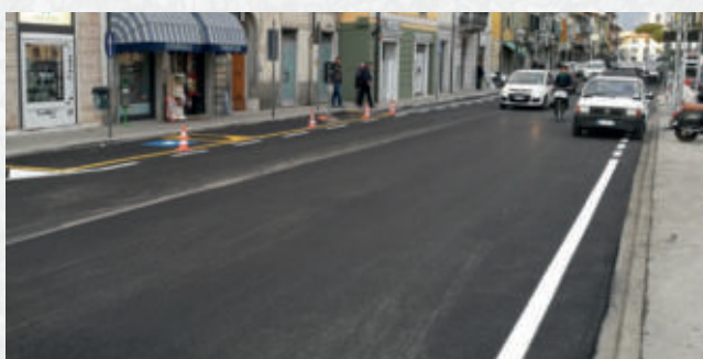
RIFACIMENTO MANTO STRADALE
